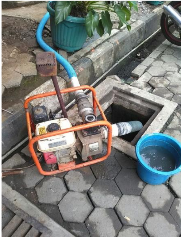
Mesin penyedot air digunakan oleh teknisi untuk menyedot saluran air yang mampet
