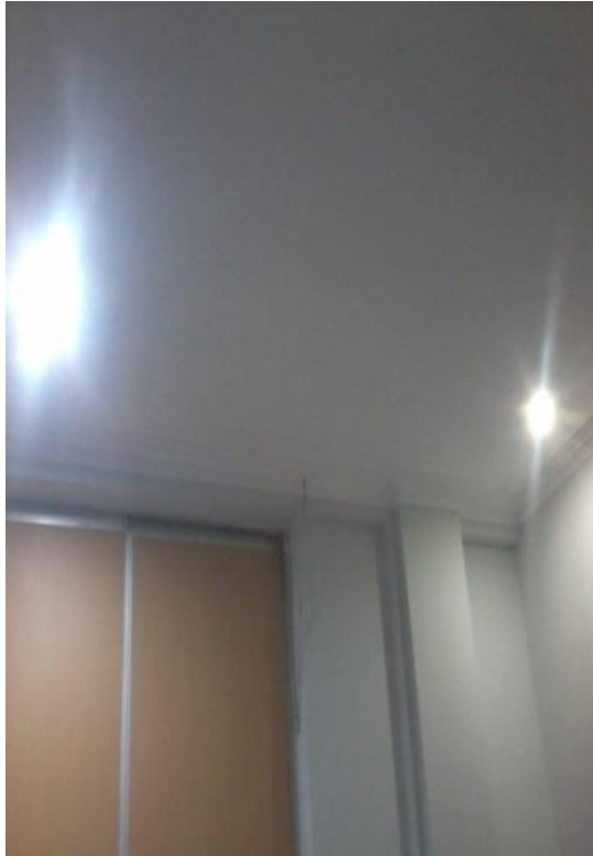
Lampu penerangan di ruang kerja
