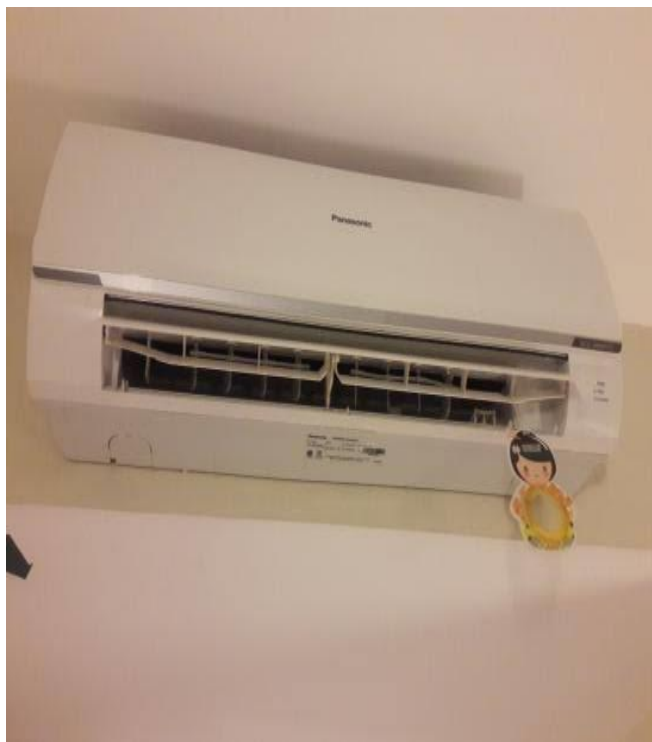
AC 2 PK Merk Panasonic Type CS-C18CKF di ruangan kerja Staf Akunting dengan luas 36 M2
